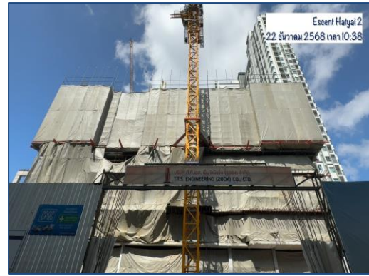
รูปที่ 56 ติดตั้งผ้าใบก่อสร้าง (Mesh Sheet) คลุมตัวอาคาร
