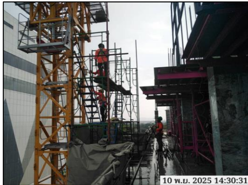
รูปที่ 62 ติดตั้งนั่งร้านบันไดทางขึ้น-ลง
