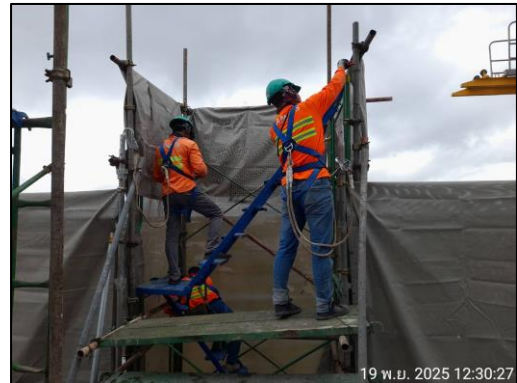
รูปที่ 62 ติดตั้งนั่งร้านบันไดทางขึ้น-ลง
