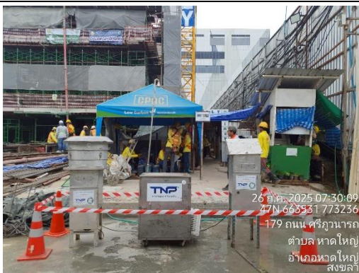
รูปที่ 39 ติดตั้งเครื่องตรวจวัดคุณภาพอากาศโดยทั่วไป
