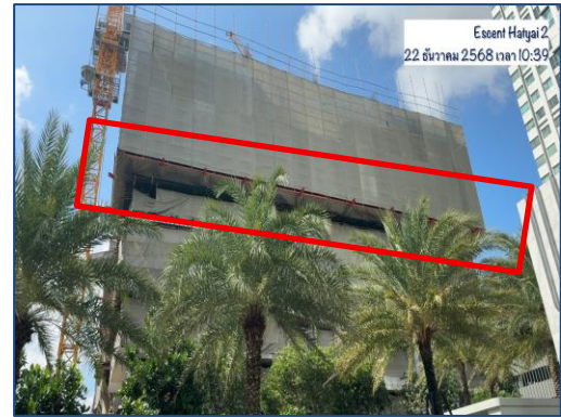
รูปที่ 61 ติดตั้ง Protection ป้องกันวัสดุร่วงหล่น
