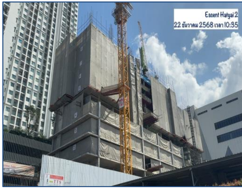
รูปที่ 56 ติดตั้งผ้าใบก่อสร้าง (Mesh Sheet) คลุมตัวอาคาร
